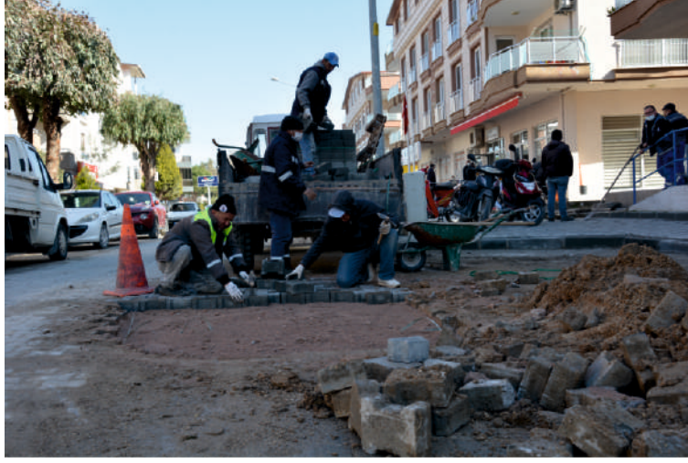
İsmetpaşa Mahallesi 12 Sokak kilit parke taş yol tamirâtı.
