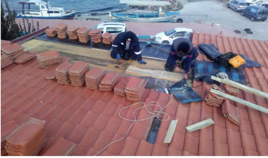
Gazipaşa Mahallesi Yakamoz Kafe çatı tamirati.
