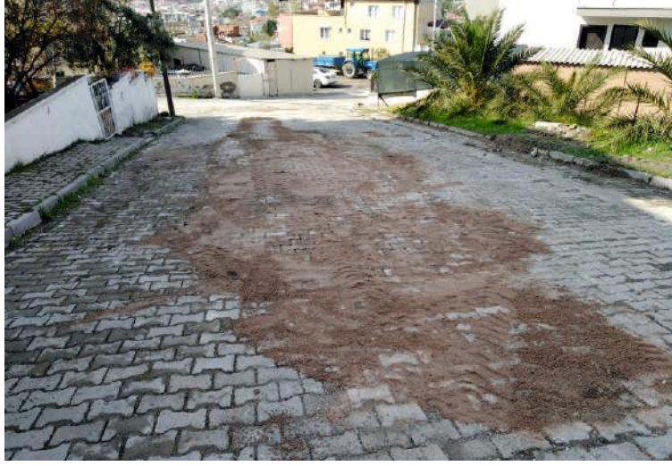
İsmetpaşa Mahallesi 111 Sokak kilit parke yol tamirâtı.
