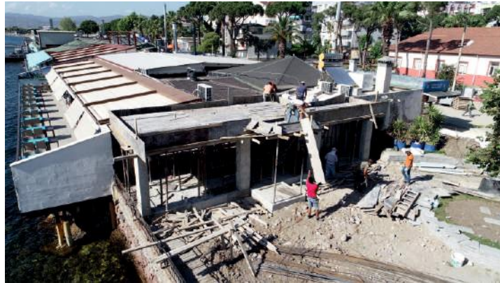
Salimbey Mahallesi Muammer Aksoy Parkı tuvalet yapımı.
