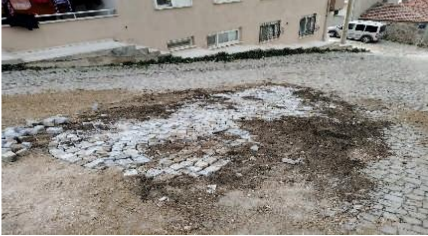
İsmetpaşa Mahallesi 95 Sokak parke taş tamirati.
