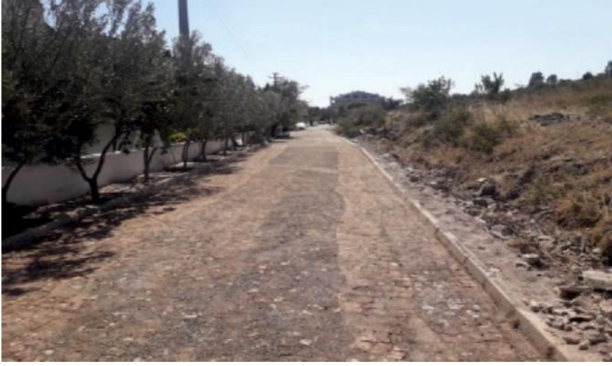
Kocaoba Mahallesi dere yataklarından geçişlerin düzenlenmesi.
