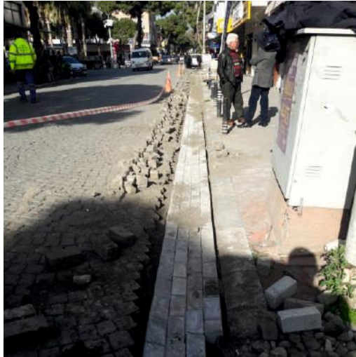
Salimbey Mahallesi Şehit Sami Akbulut Caddesi yağmur oluğu tamirati.
