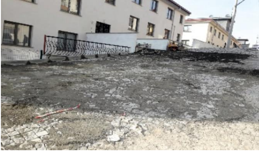
İsmetpaşa Mahallesi 70/1 Sokak yol tamirati.
