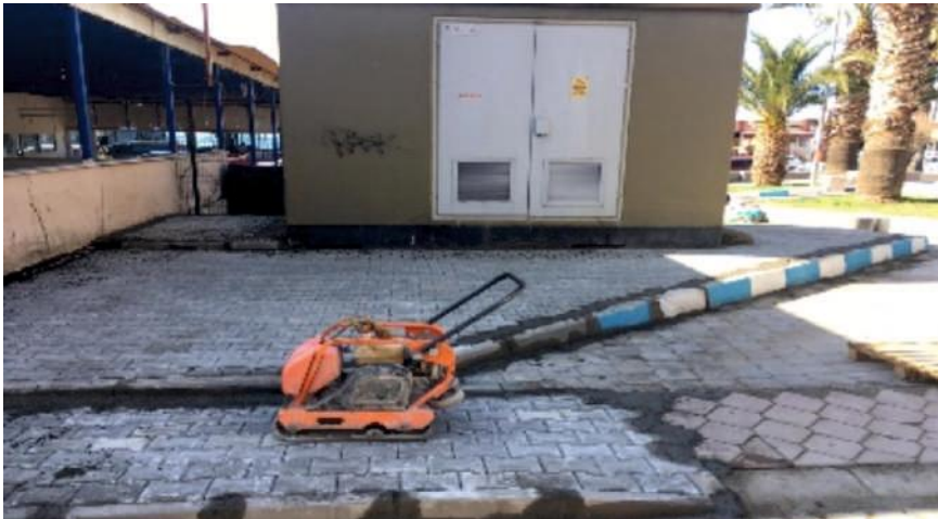
İsmetpaşa Mahallesi 102 Sokak trafo kaldırımı tamirati.
