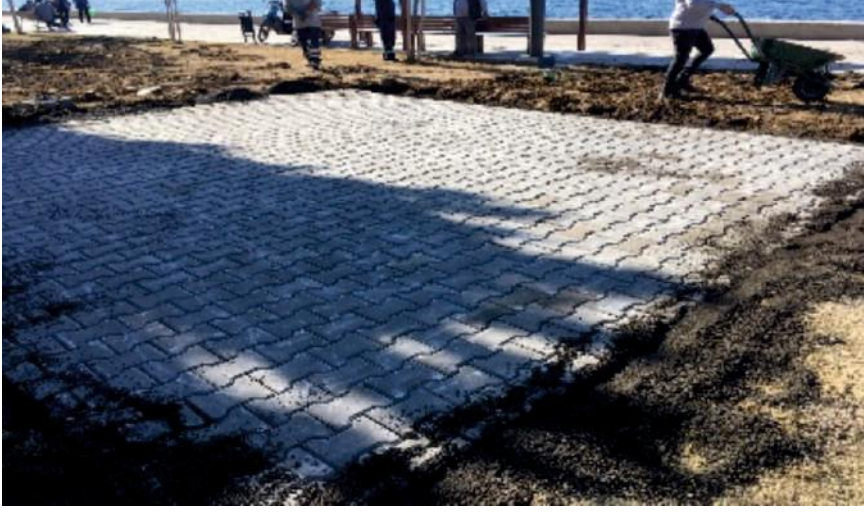
Gazipaşa Mahallesi 75. Yıl Parkı Palmiye Kafe zemin yapımı.
