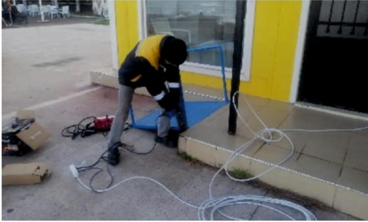
Gazipaşa Mahallesi Bilim Evi engelli rampası yapılması.
