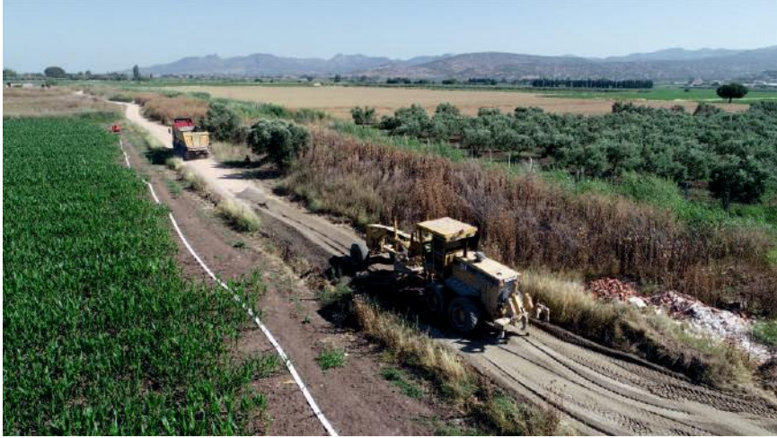
Kabakum Mahallesi 33 Sokak Üretim Yolu stabilize yol yapımı.
