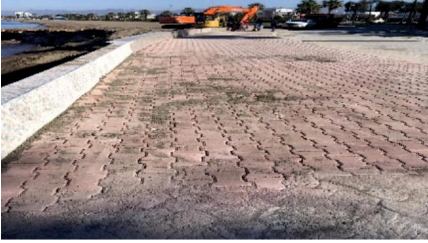
İsmetpaşa Mahallesi Atatürk Caddesi sahil boyu taş tamirati.
