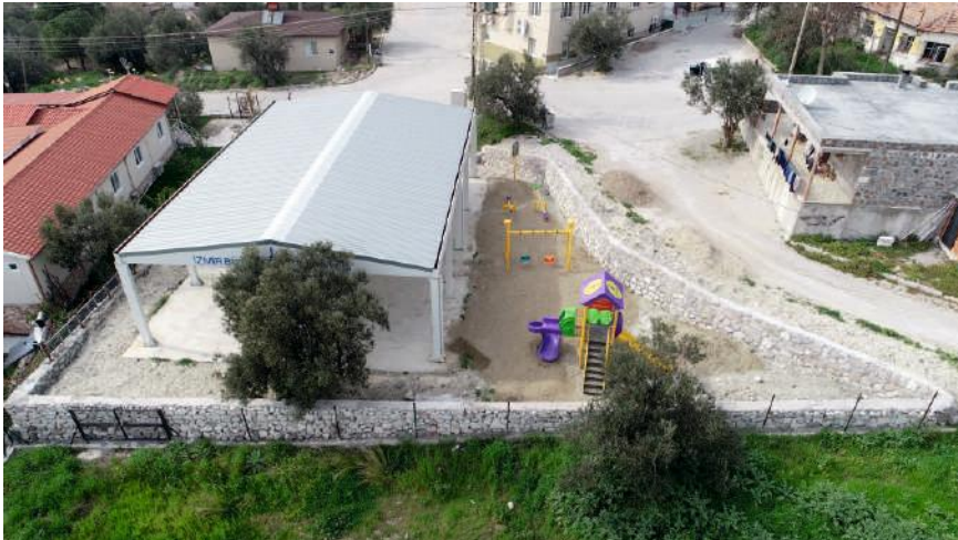
Kabakum Mahallesi oyun grubu alanı zemin tasfiyesi.
